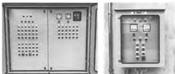
Control Panel Main WWTP - Control Panel IRP-01 และ IRP-02
